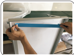
01 对安装表面进行胶贴，起固定位置作用；
